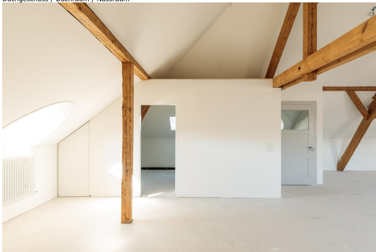
Dachgeschoss / Dachraum / Nassraum
